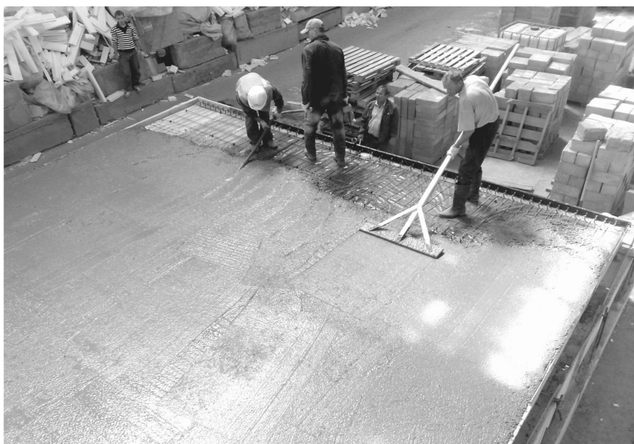
Рис. 2. Процесс замоноличивания железобетонной плиты
