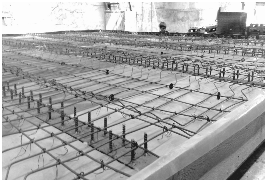
Рис. 1. Армирование плиты сталежелезобетонного перекрытия
