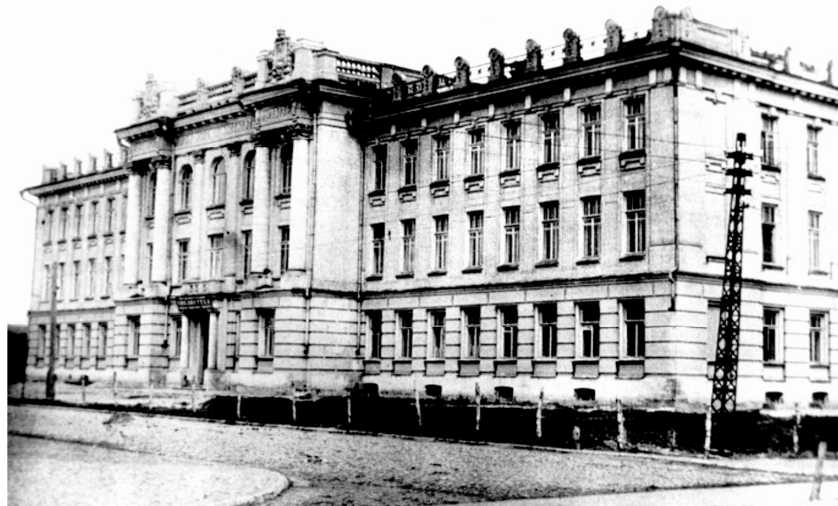
Рис. 3. Фасад Физического института со стороны ул. Университетская
