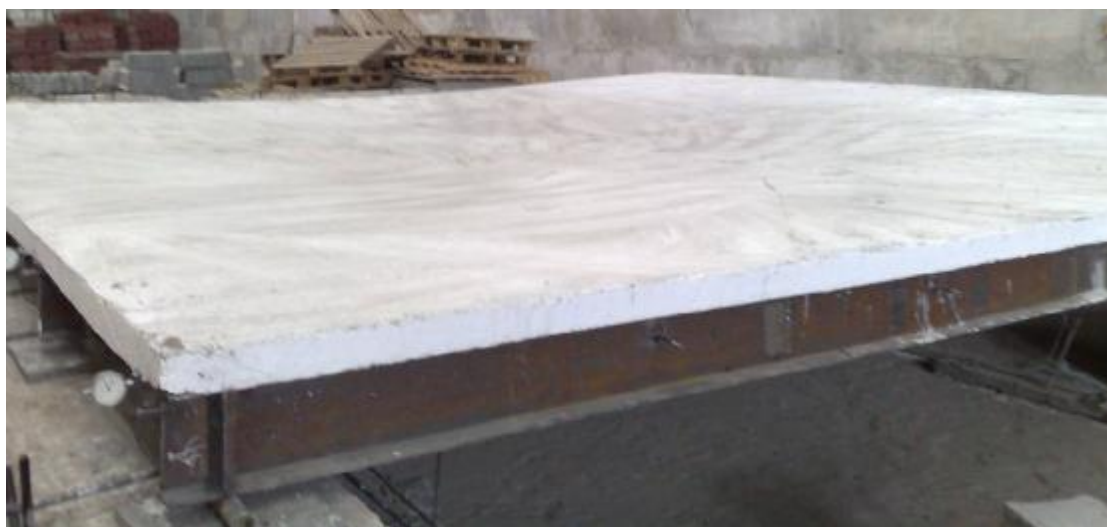
Рис. 3. Общий вид опытной сталежелезобетонной плиты после испытания
