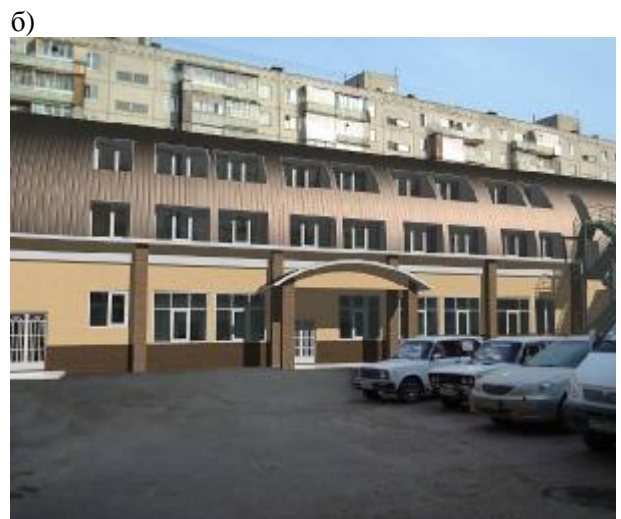
Рис. 3. Реконструкция одноэтажного здания Уфимского филиала РГСУ с надстройкой двух дополнительных этажей, в качестве стенового ограждения использован прокатный профнастил (наружный слой) с заполнением внутреннего слоя крупнопористым керамзитобетоном: а) вид здания до реконструкции; б) вид здания после реконструкции
