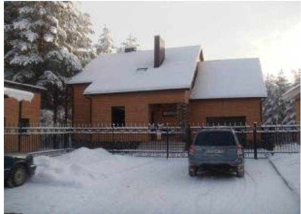
Рис. 5. Главный (а) и дворовой (б) фасады коттеджа в г. Белебей с мансардой, а также наружными стенами, выполненными в колодцевой кладке с применением крупнопористого керамзитобетона
