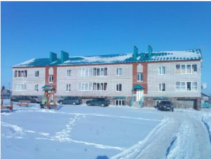
Рис. 2. Главный фасад двухэтажного жилого дома с цокольным этажом, наружные стены из керамзитобетонных блоков с кирпичной облицовкой (п. Кармаскалы, ул. Ленина, 39 Б)
