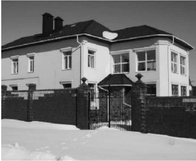
Рис. 4. Коттедж в п. Михайловка Уфимского района с наружными стенами, выполненными в колодцевой кладке и внутренним слоем из крупнопористого керамзитобетона
