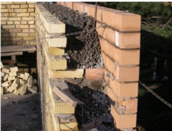
Рис. 6. Наружная стена коттеджа в г. Белебей, выполненная в колодцевой кладке с внутренним слоем из крупнопористого керамзитобетона в стадии строительства
