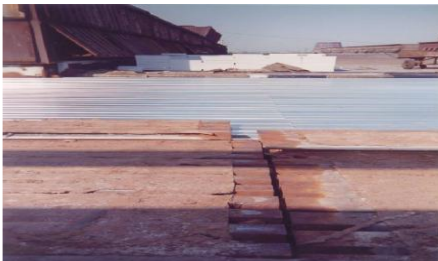
Рис. 3. Укладка настила без нахлестки
