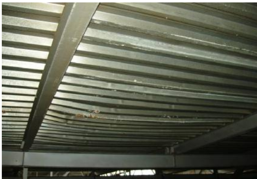
Рис. 2. Деформированный участок профилированного настила
