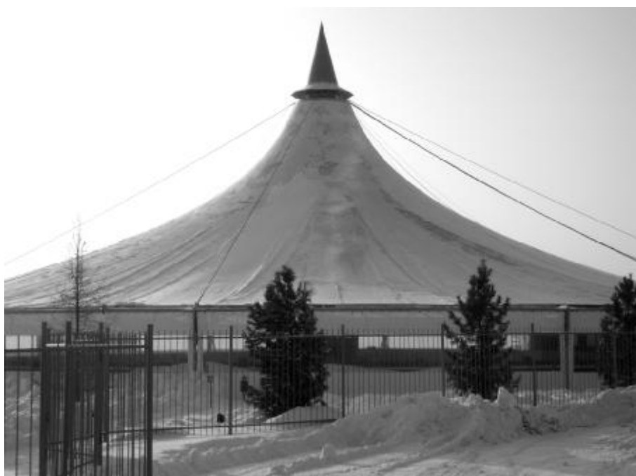
Рис. 8. Эксплуатация сооружения в зимний период сопровождается очисткой поверхности тента от снега
