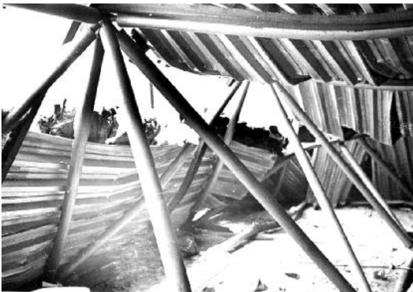
Рис. 1. Обрушение покрытия из структурных конструкций зимой 1976 года
