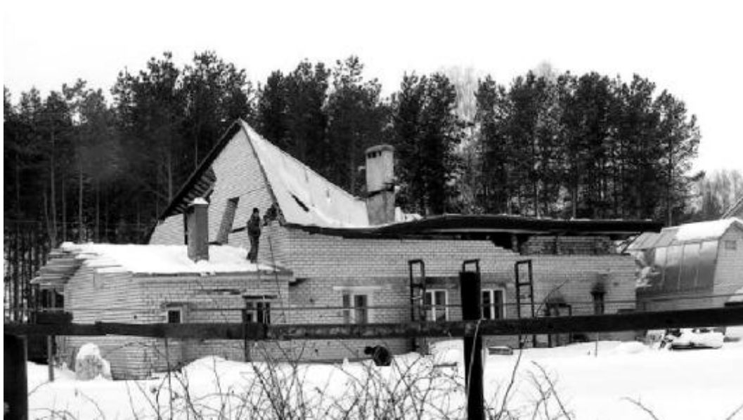
Рис. 4. Обрушение кровли одноэтажного жилого дома 7 марта 2006 года
