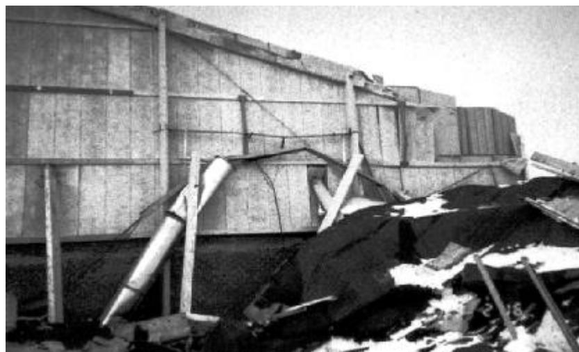
Рис. 2. Обрушение каркаса крытого катка в городе Лениногорске РТ в марте 1998 года
