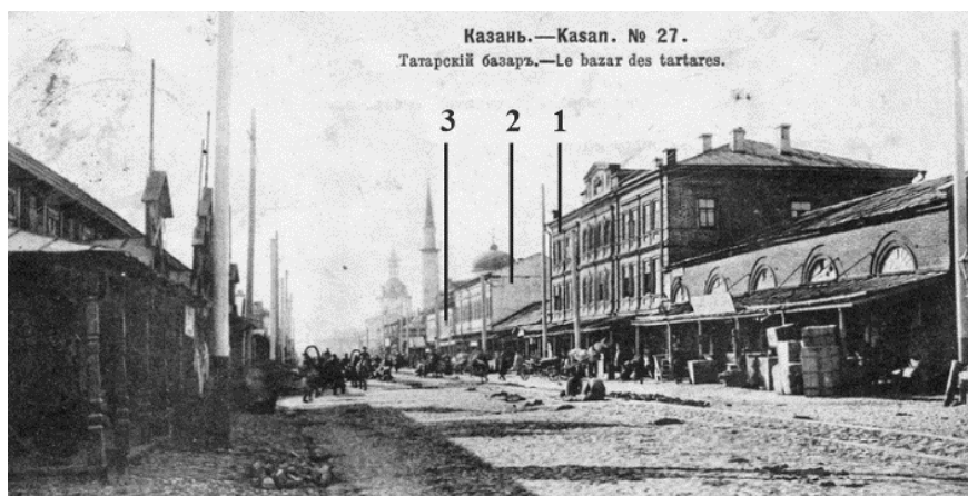
Рис. 2. Сенной базар. Вид на: 1) трехэтажный доходный дом братьев И.Г. и И.Г. Юнусовых, 1877 г., арх. А. Пермяков 2) доходный дом братьев И.Г. и И.Г. Юнусовых (перестроен в 1912 г. под номера «Амур»), 3) доходный дом И.И. Апакова - М.И. Шамиля - М.М. Галеева.
