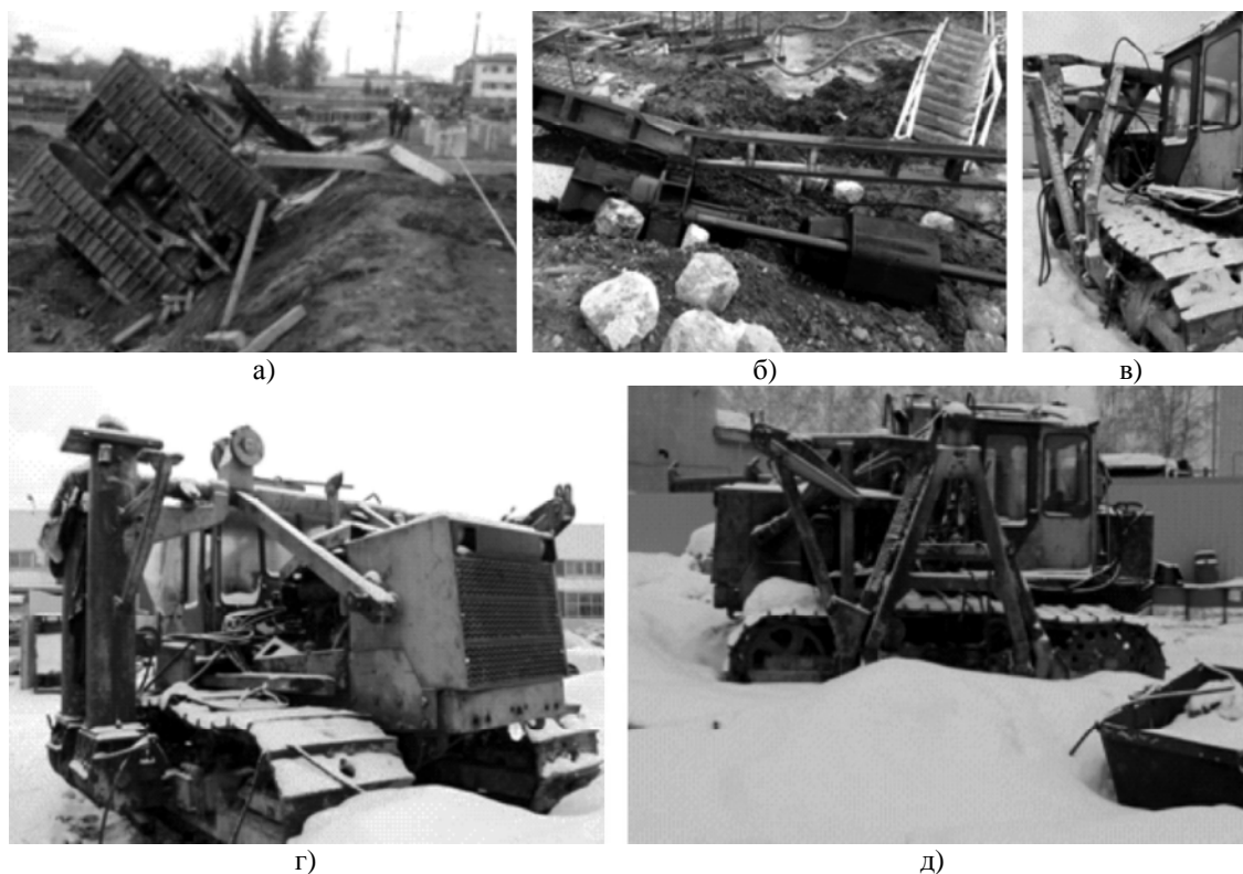
Рис. 1. Фотографии копровой установки: а, б – на месте аварии; в, г, д – после демонтажа
