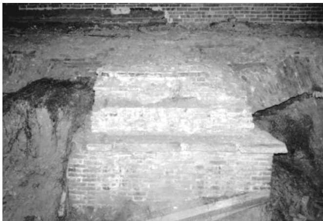
Рис. 5. Каменный контрфорс и опирающиеся на него арки барбетных площадок [5]
