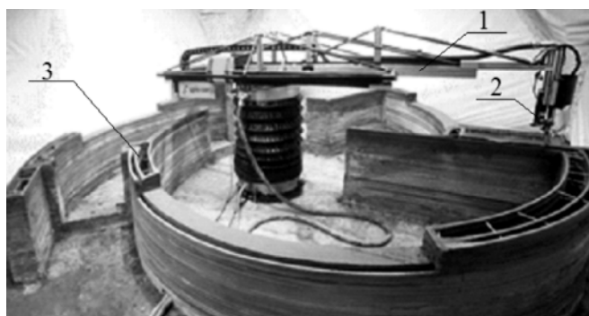
Рис. 4. Мобильный строительный 3D-принтер ArisCor, работающий в угловых координатах: 1 – стрела установки; 2 – экструдер; 3 – изготавливаемая ограждающая конструкция
