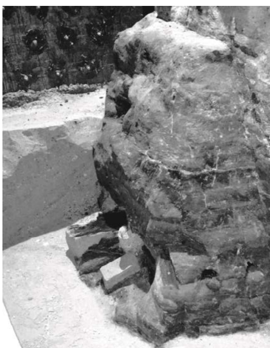
Рис. 8. Фрагмент фундамента деревоземляного бастиона (строительство 1703 г.)
