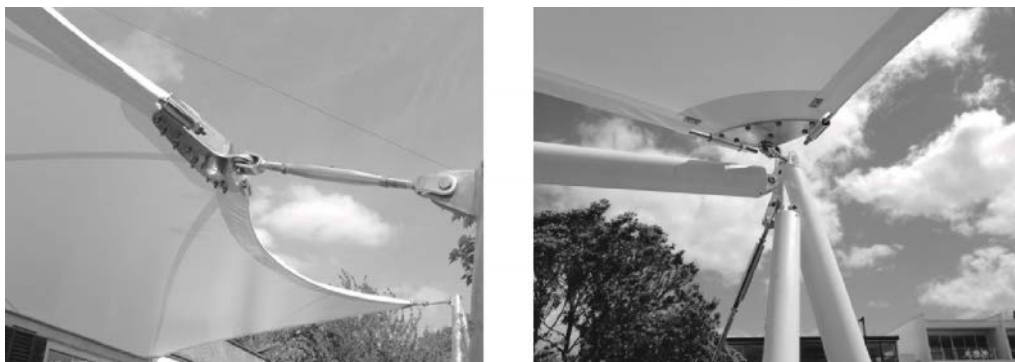
Рис. 3. Катенарный пояс и узлы крепления и натяжения тентовой оболочки
