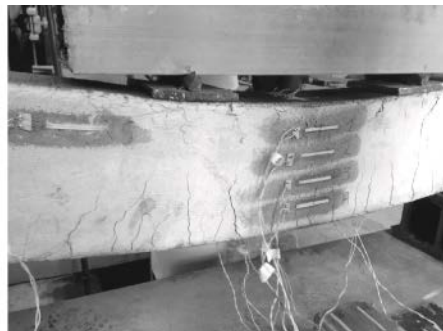
Рис. 10. Характер разрушения сталежелезобетонных балок
