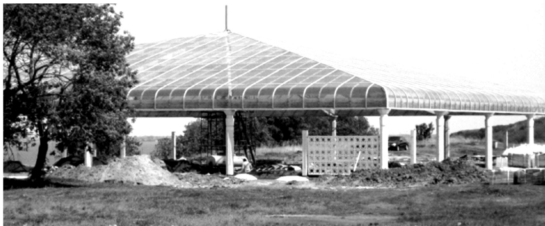
Рис. 1. Несущие конструкции укрытия защитного сооружения над руинами Ханского дворца в г. Булгары РТ. Период монтажа клееных деревянных балок
