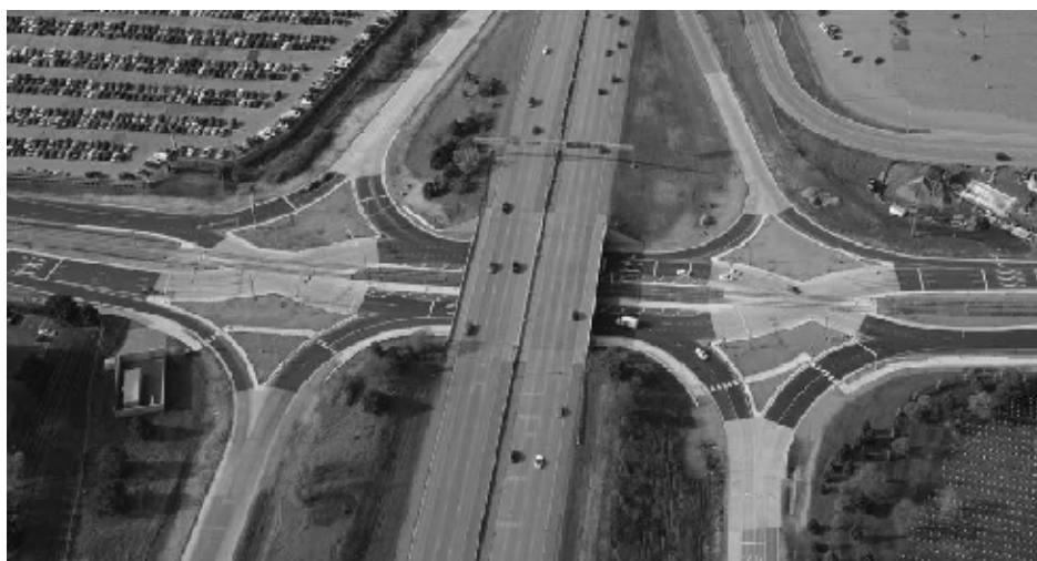
Рис. 4. Изменение сторон движения под путепроводом
