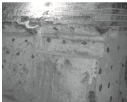
Рис. 1. Сохранившаяся и новая кирпичная кладка
