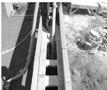
Рис. 4. Заливка монолитного пеногипса в конструкцию каркасной наружной стены
