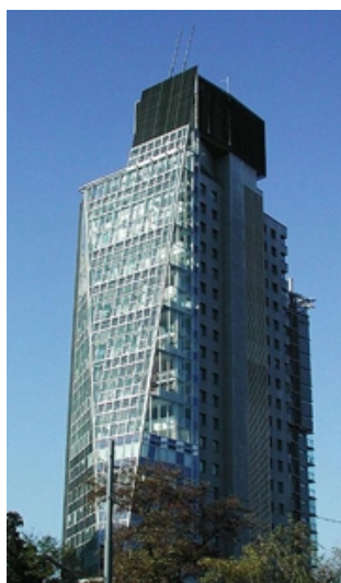
Рис. 10. Жилое здание «ZEG-Tower». Вена, 1998 г.
