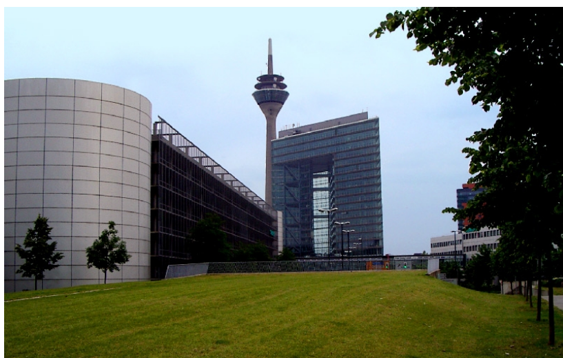
Рис. 16. Здание «Городские ворота Дюссельдорфа». Общий вид
