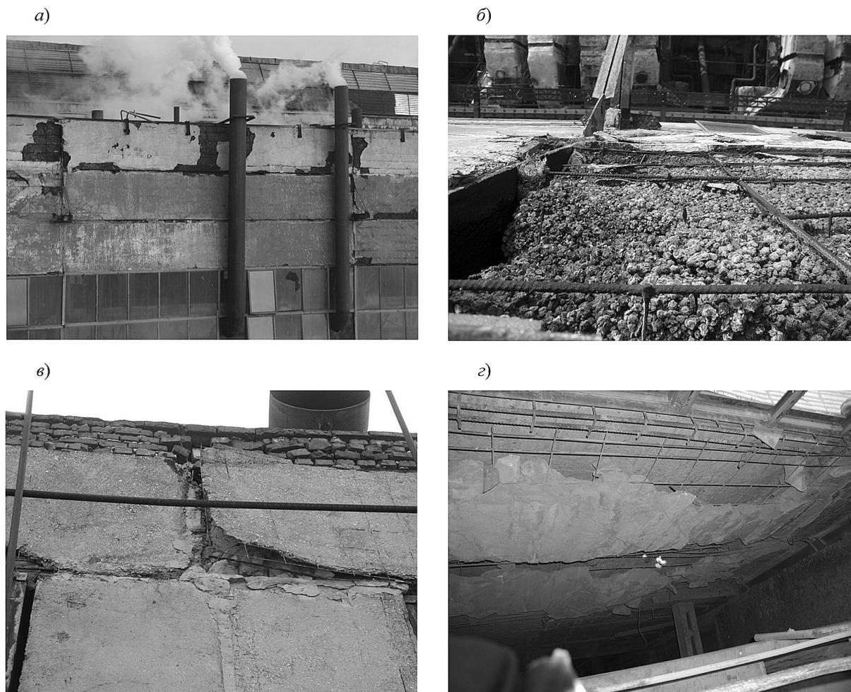
Рис. 2. Повреждения стеновых панелей, связанные с разрушением наружных и внутреннего слоев
