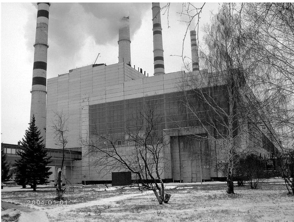
Рис. 1. Главный корпус Заинской ГРЭС: длина 522 м, ширина 81 м, максимальная высота 54 м
