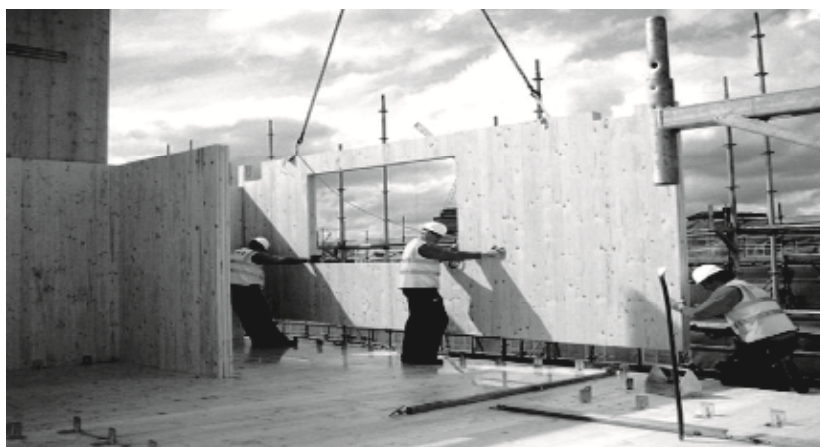
Рис. 2. Процесс монтажа CLT-панели
