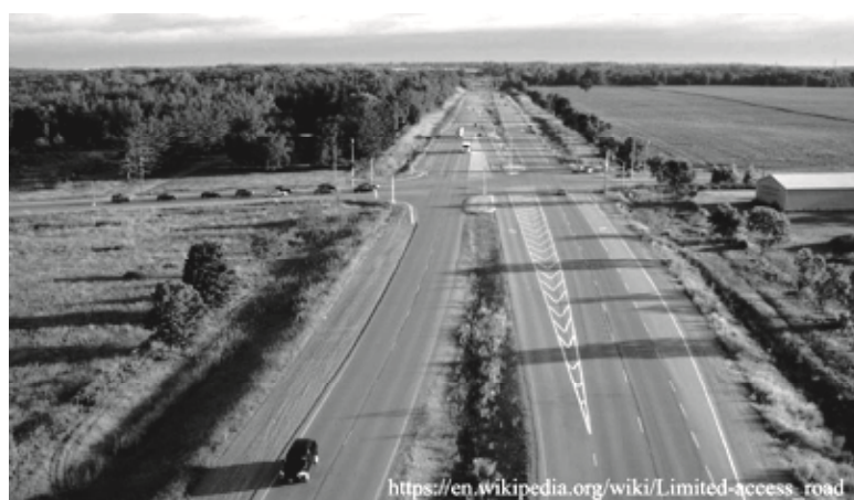
Рис. 2. Одноуровневое пересечение на скоростной магистрали, Канада
