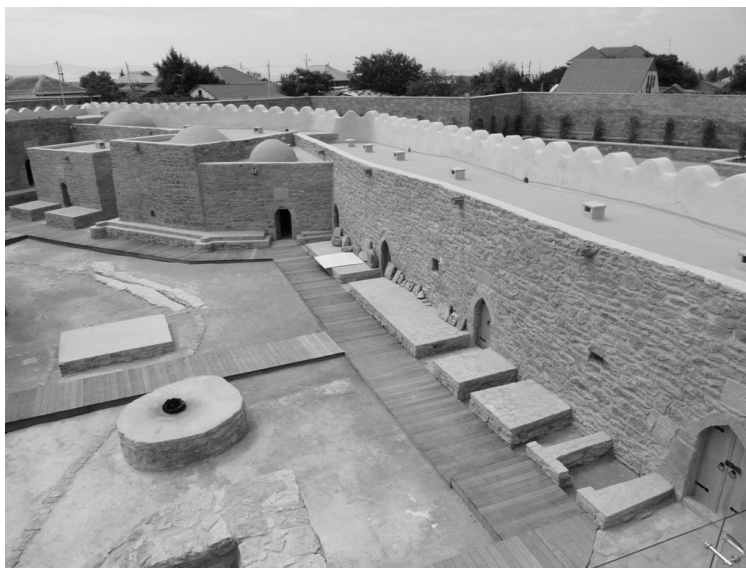
Рис. 4. Состояние покрытий до и после реставрационных работ
