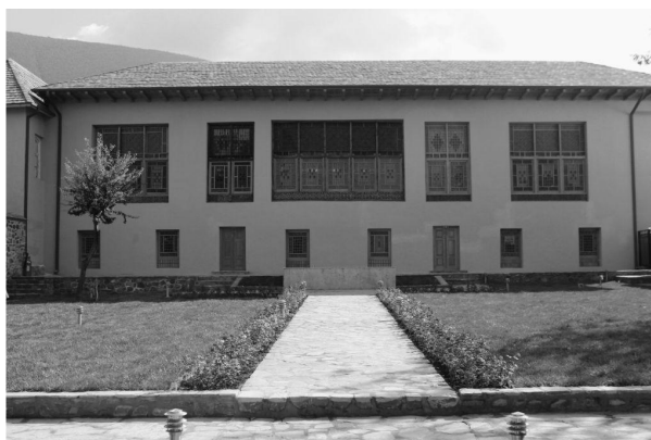
Рис. 1. Фасад Дома Шекихановых после реставрации
