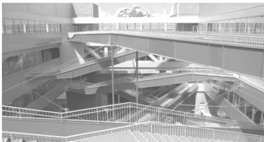
Рис. 5. Внутренний двор кампуса Института Нано Систем Университета Калифорнии в Лос-Анджелесе (арх. Рафаэль Виньоли)
